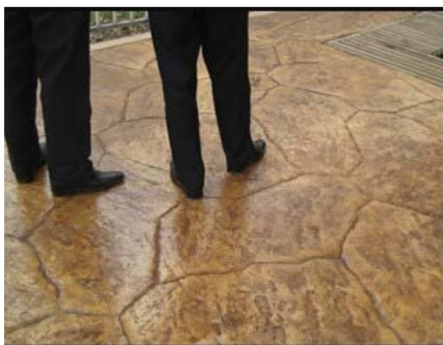
10 使用真石丽艺术压模地坪材料完工后的成品效果
